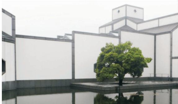
图5 苏州博物馆新馆的墙体形式
