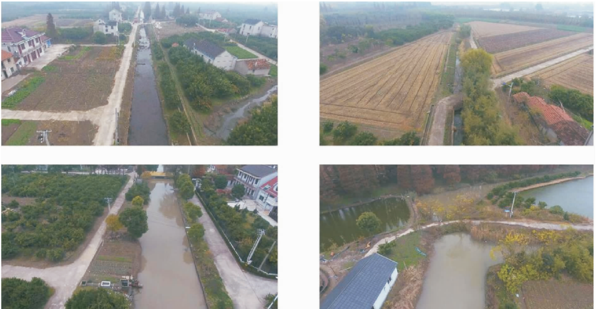
图3 上海市崇明区绿华镇河道现状航拍图
